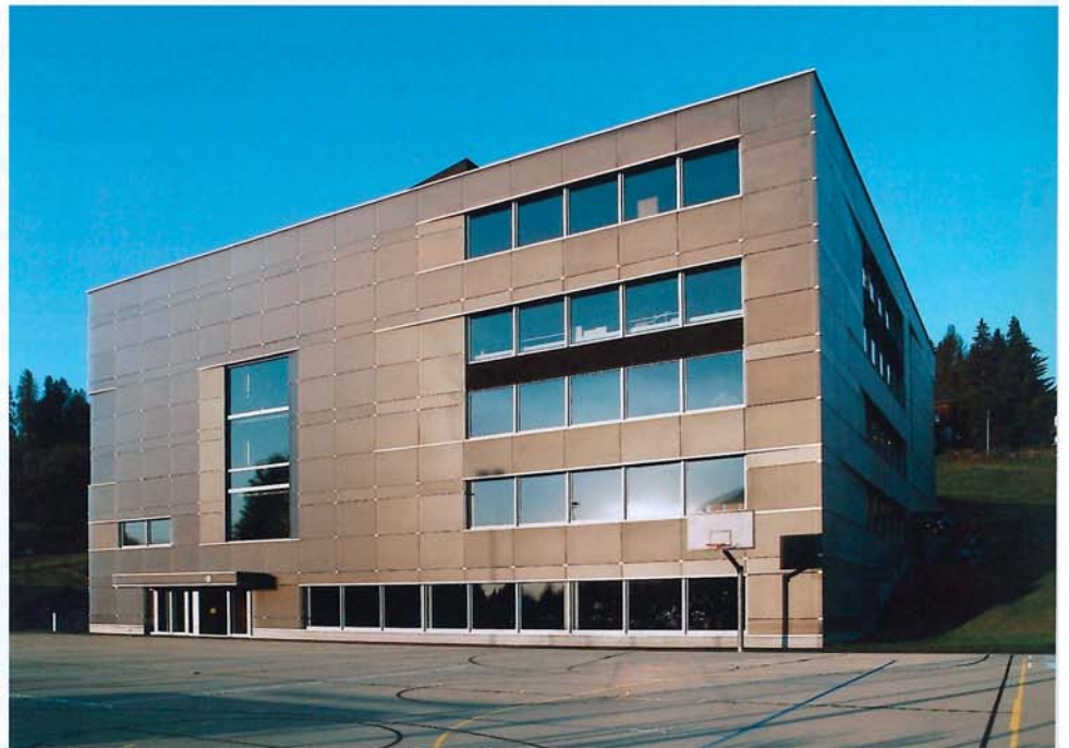
Lageplan | Ansicht von Süden | Blick in den Korridor des dritten Geschosses mit Brückenverbindung zu den Unterrichtsbereichen | Blick in die Turnhalle, der Schnittstelle zwischen Grundschule und Oberstufe
